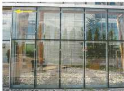
Abb. 3: Bei geschlossenen Fenstern nutzten die Elstern Lücken an den Rolltoren zum Einflug. – In case windows were closed, Magpies used gaps in gates for entering the building.
