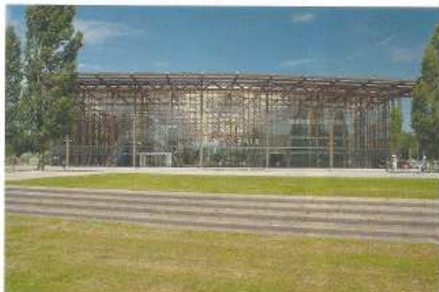
Abb. 1: Die Akademie Mont Cenis in Herne-Sodingen. – The academy Mont Cenis in Herne-Sodingen. Alle Fotos: N. KILMANN
